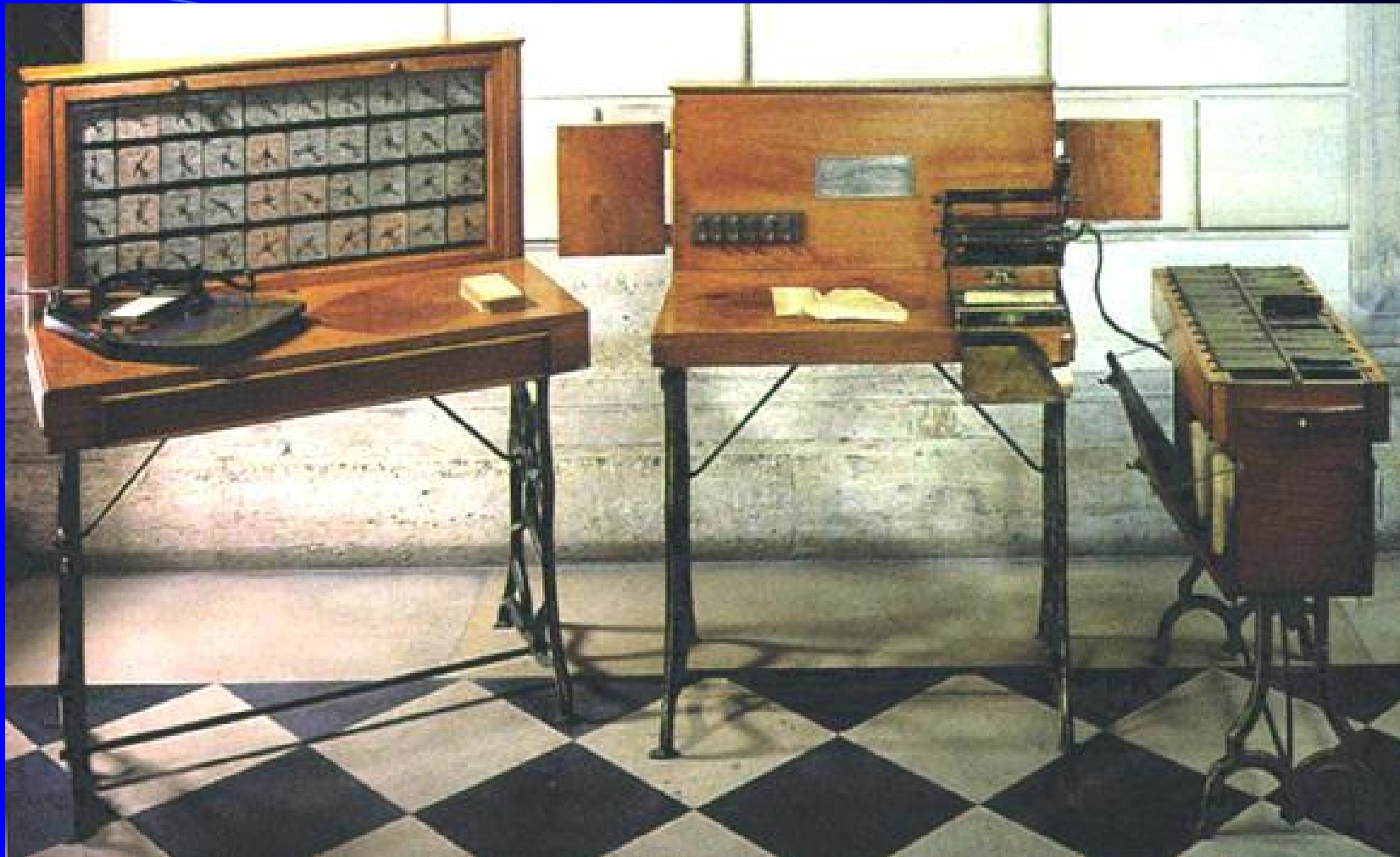
Machine statistique de H. HOLLERITH – 1889 Automatiser le recensement de 1889 aux Etats unis
